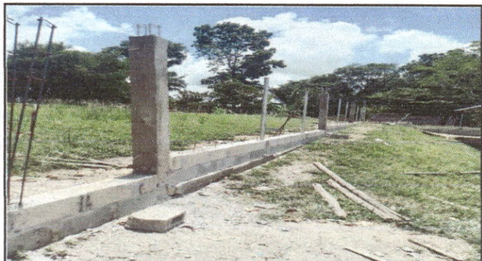
Foto 4: Se observa la reparación del cerco perimetral.
