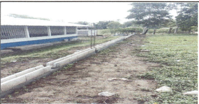
Foto 5: Se observa la reparación del cerco perimetral.
