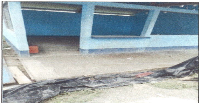
Foto 6: Se observa la reparación del piso
