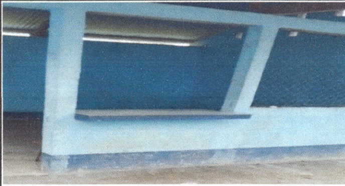
Foto 1: se observa la reparación de balcones.
