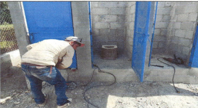
Foto 3: Se observa la reparación del baño.
