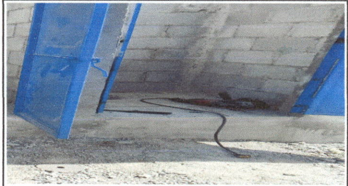
Foto 2: Se observa la reparación de puerta.
